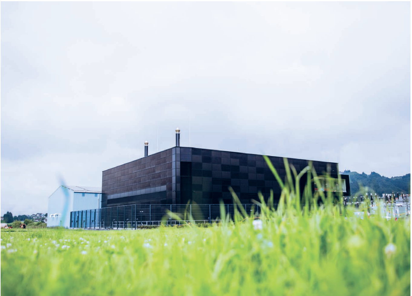
Das Rechenzentrum Ostschweiz in Gais Fotografie: St. Galler Tagblatt/Mareycke Frehner
