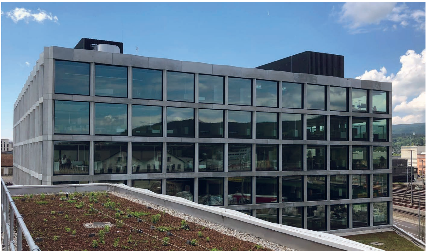
Blick vom Werkhof auf das eniwa-Bürogebäude Fotografie: Christoph Wey
