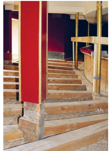
Foto aus dem Stadttheater Solothurn; Christoph Wey Architekten: phalt architekten ag, Zürich
