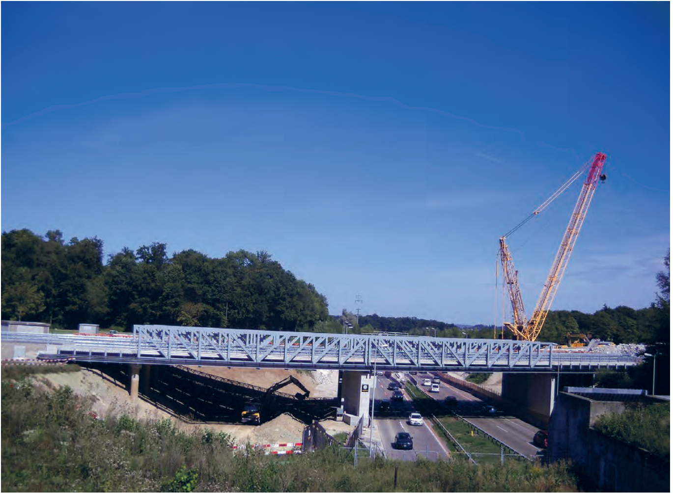
A1: prov. Hilfsbrücke Affolternstrasse mit prov. Trafostation links im Bild
