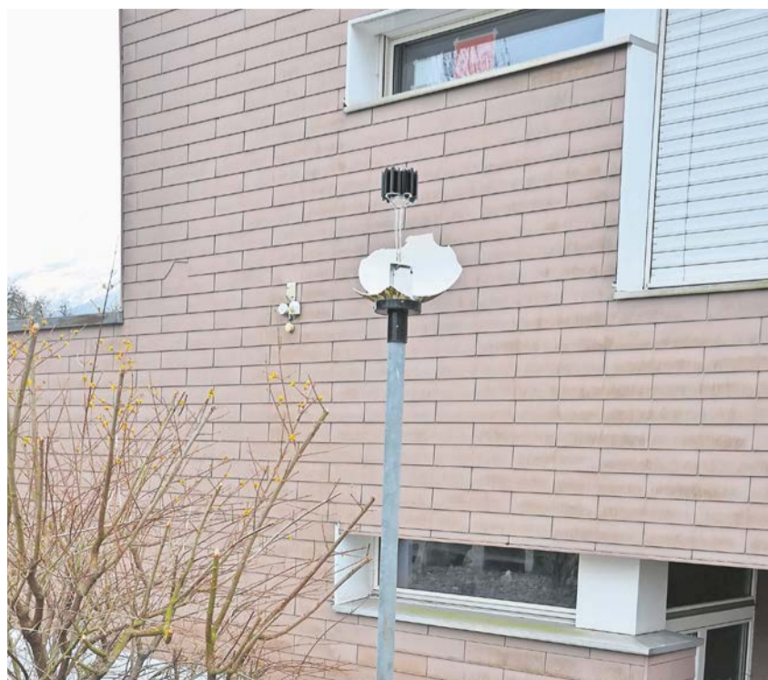
Eine von mehreren Kandelaber-Lampen auf dem Areal der Kreisschule Seedorf, die von Vandalen mutwillig zerstört wurde. FOTO: SIMON GISLER
